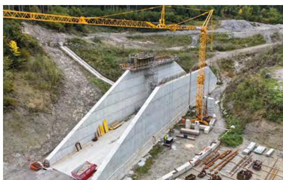
Die Retentionsanlage besteht aus einem abgedichteten Erddamm mit einem zentralen, betonierten Mittelteil.
