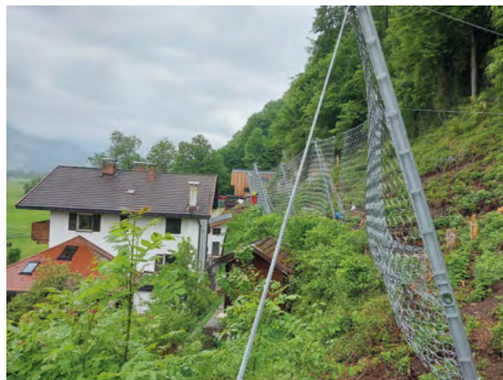
104 Meter Steinschlagschutznetze hat die WLV am Hechenberg errichtet.
