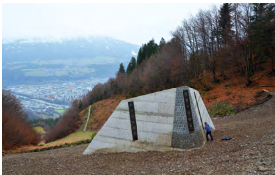
Bremskeil mit Messinstrumenten auf der Arzler Alm im Dezember 2025
