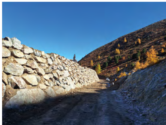
Der Lawinendamm Ahorntobel auf 2140 Metern Seehöhe.
