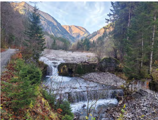
Bauwerk aus dem Jahr 1938
