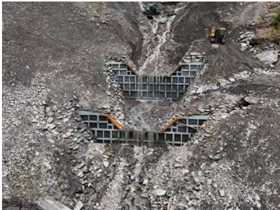
Die bestehende Sperrenstaffelung wurde um zwei Konsolidierungssperren ergänzt.
