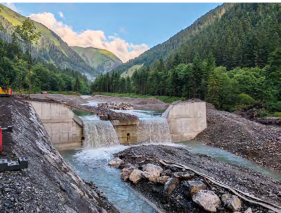
Die neue Sperre während der Bauphase.
