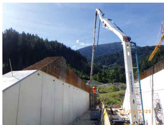
Der betonierte Mittelteil ist 21,5 Meter hoch und ermöglicht ein Retentionsvolumen von insgesamt 76.300 Kubikmetern.
